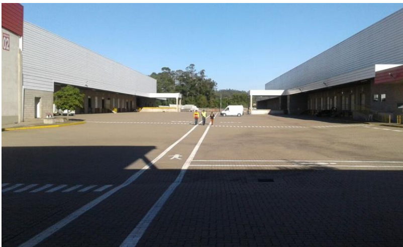
SINALIZAÇÃO PARA PEDESTRE
