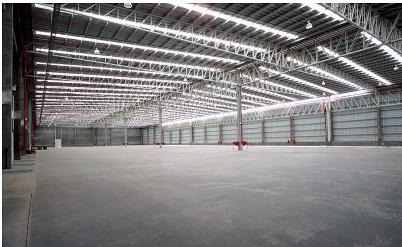
COBERTURA EM ESTRUTURA METÁLICA
